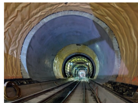
Il tunnel di base del San Gottardo.
