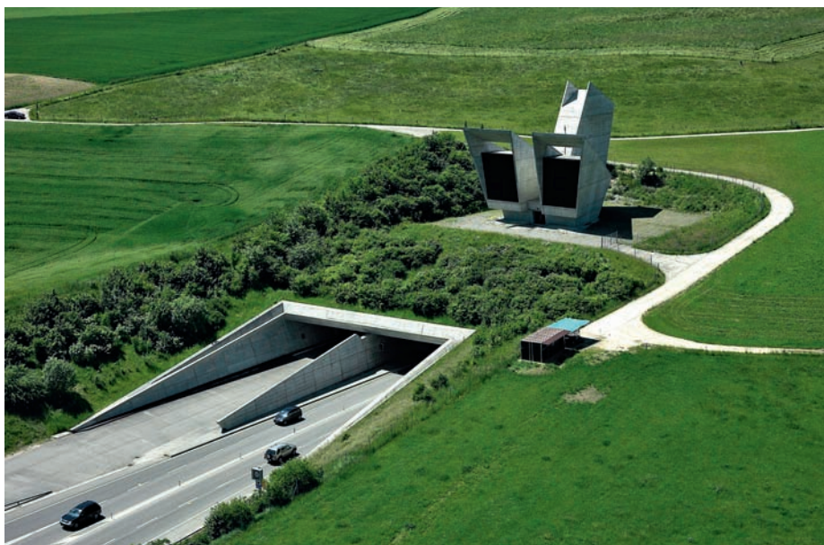
Impianto di ventilazione Monte Terri Nord nei pressi di Saint-Ursanne (Canton Giura).
