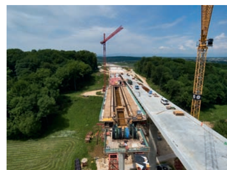
La A16 Transgiurassiana e i ponti gemelli presso Boncourt (viadotto delle Grandes Combes) progettati dall'Ufficio di Ingegneria GVH Delémont.
