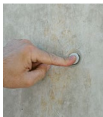
Infine chiudere i fori con i tappi - operazione conclusa!
